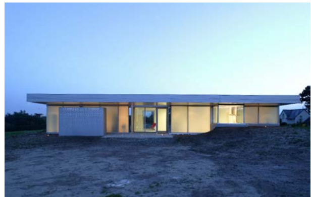
Façade principale, côté accès.
